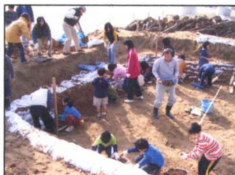
池は四角く掘り、土嚢のすき間に粘土質の土をつめていきます
